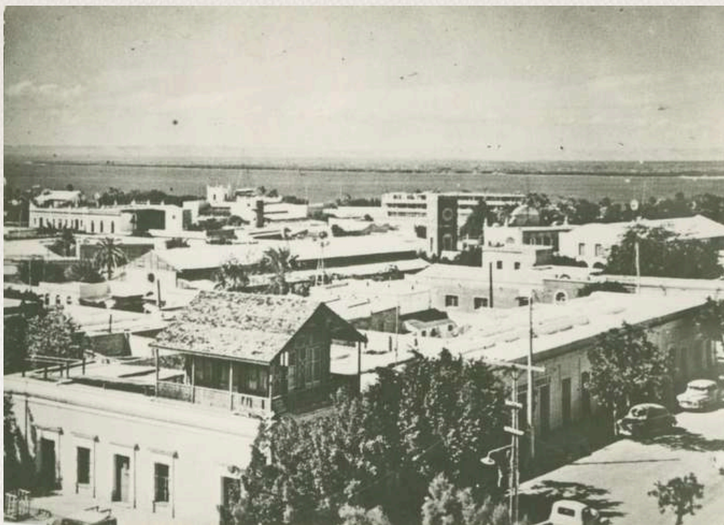
Panorámica desde la torre de la Parroquia hacia la calle Independencia y Tercera
